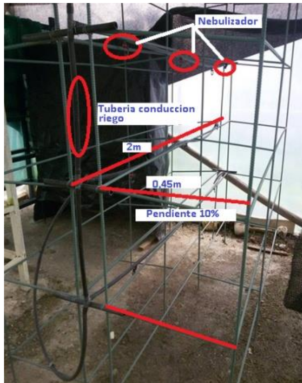
Foto 1 Adecuación de la cerchas.
