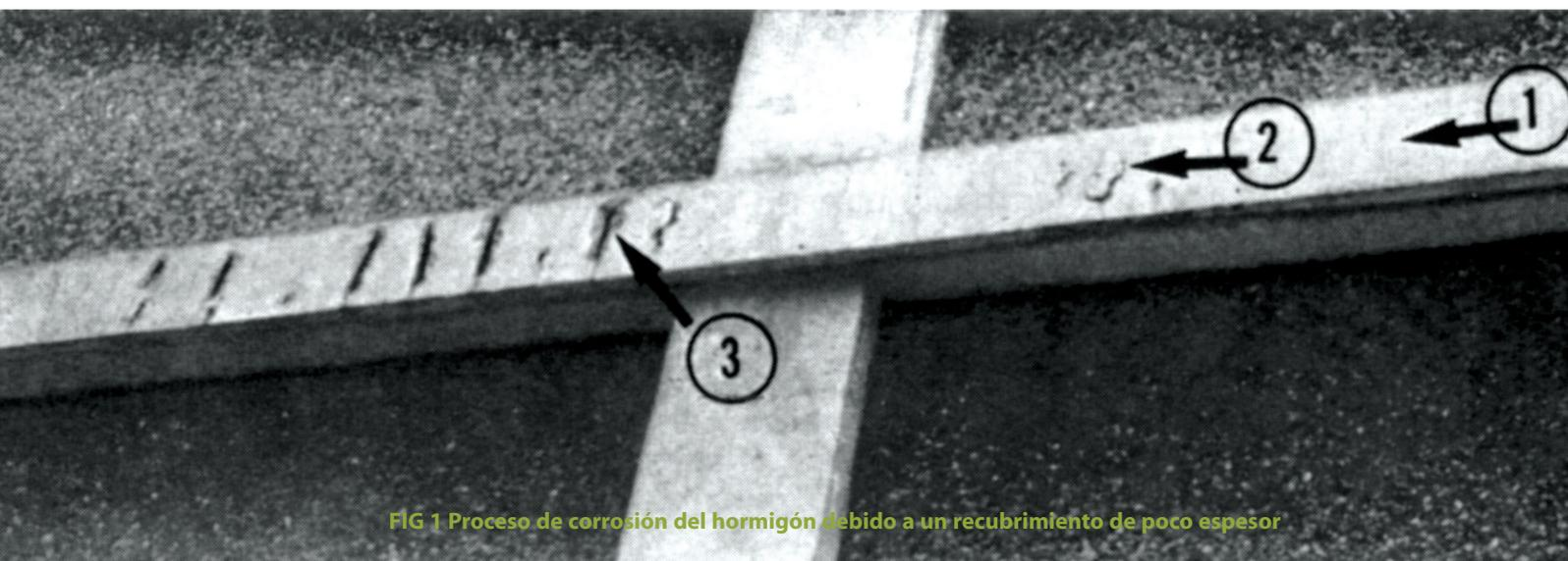
FIG 1 Proceso de corrosión del hormigón debido a un recubrimiento de poco espesor
