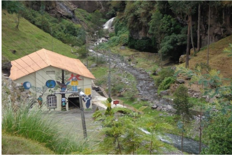
Figura 2.10. Casa de Máquinas, Central Los Chillos
