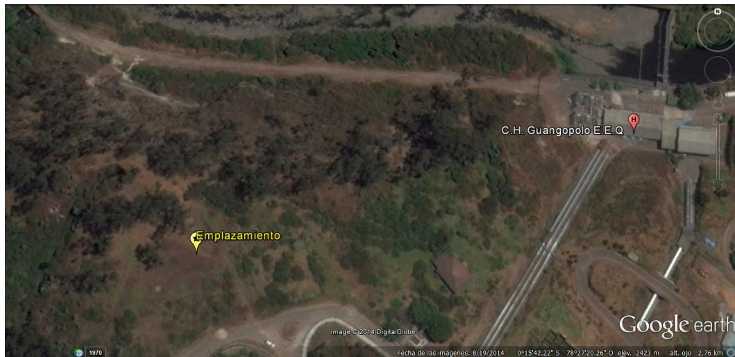
Figura 2.3. Emplazamiento asociado a la central hidroeléctrica Guangopolo
