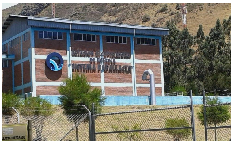
Figura 2.26. Casa de Máquinas, Central Recuperadora
