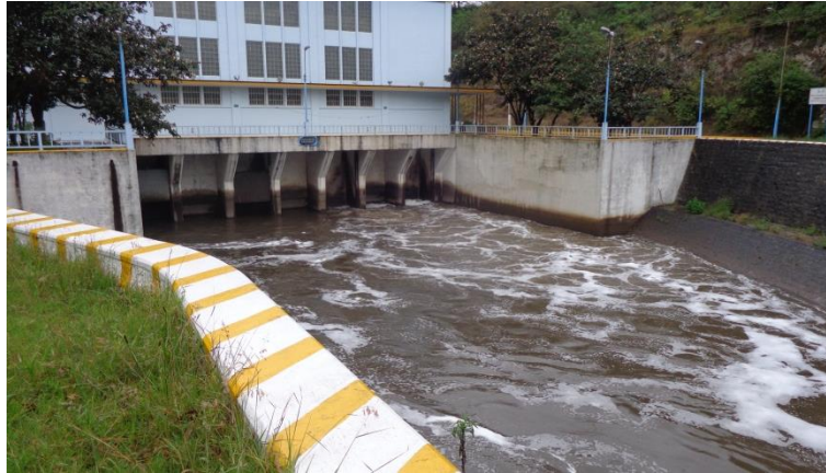
Figura 3.1. Canal de descarga-Central Cumbayá.
