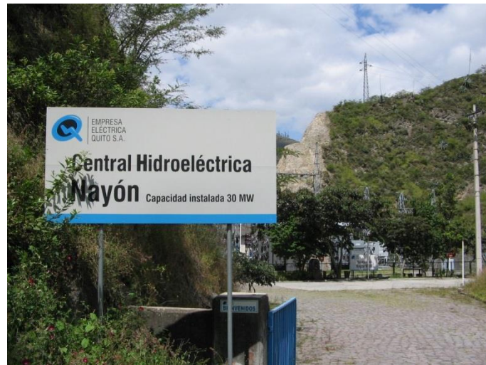
Figura 2.14. Central Hidroeléctrica Nayón
