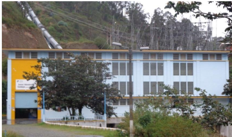
Figura 2.36. Casa de máquina-Central Cumbayá
