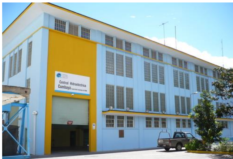
Figura 2.6. Casa de Máquinas, Central Cumbayá
