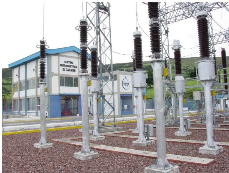
Figura 2.22. Casa de Máquinas, Central El Carmen
