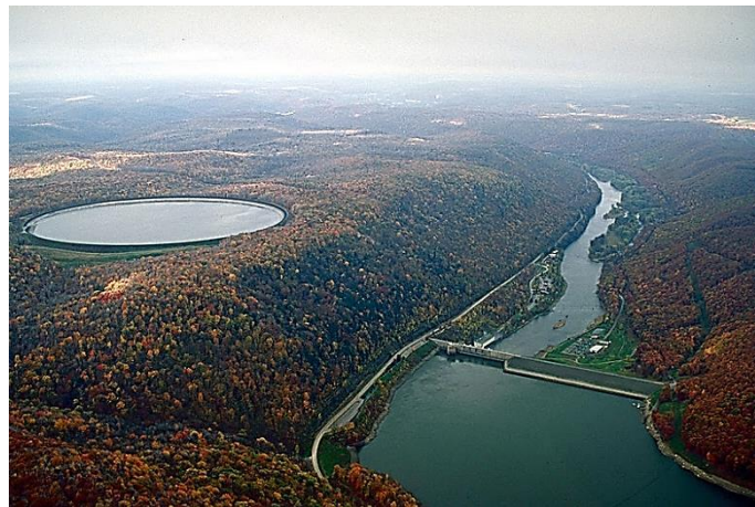
Figura 1.2. Piscina artificial como reservorio superior de la central.
