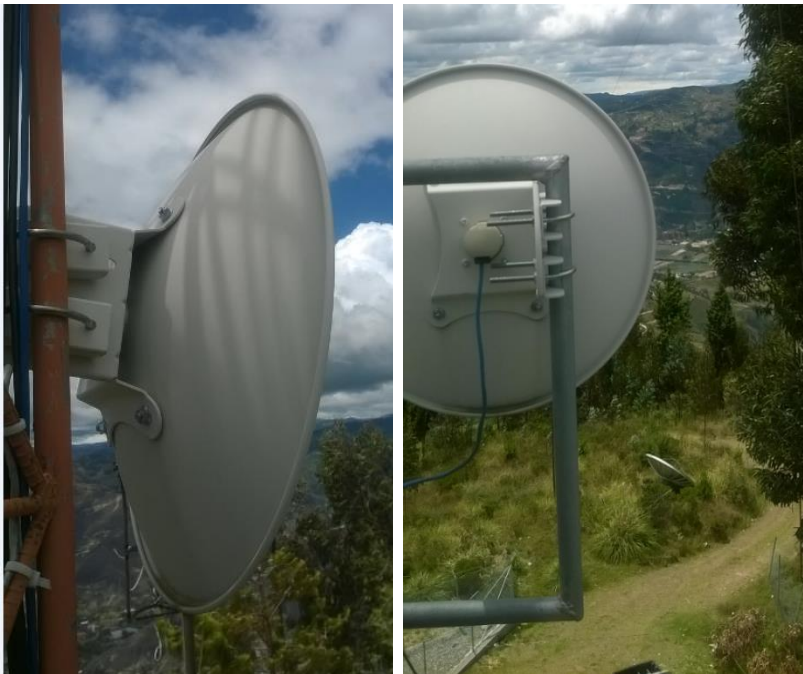
Figura 6.1 Instalación de Soportes Tipo Bandera del Nodo Principal Fuente: Autor
