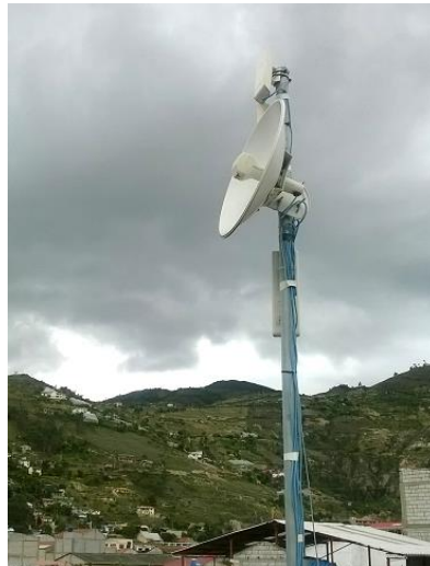
Figura. 2.6 Vista del Nodo Secundario 2 Fuente: Autor
