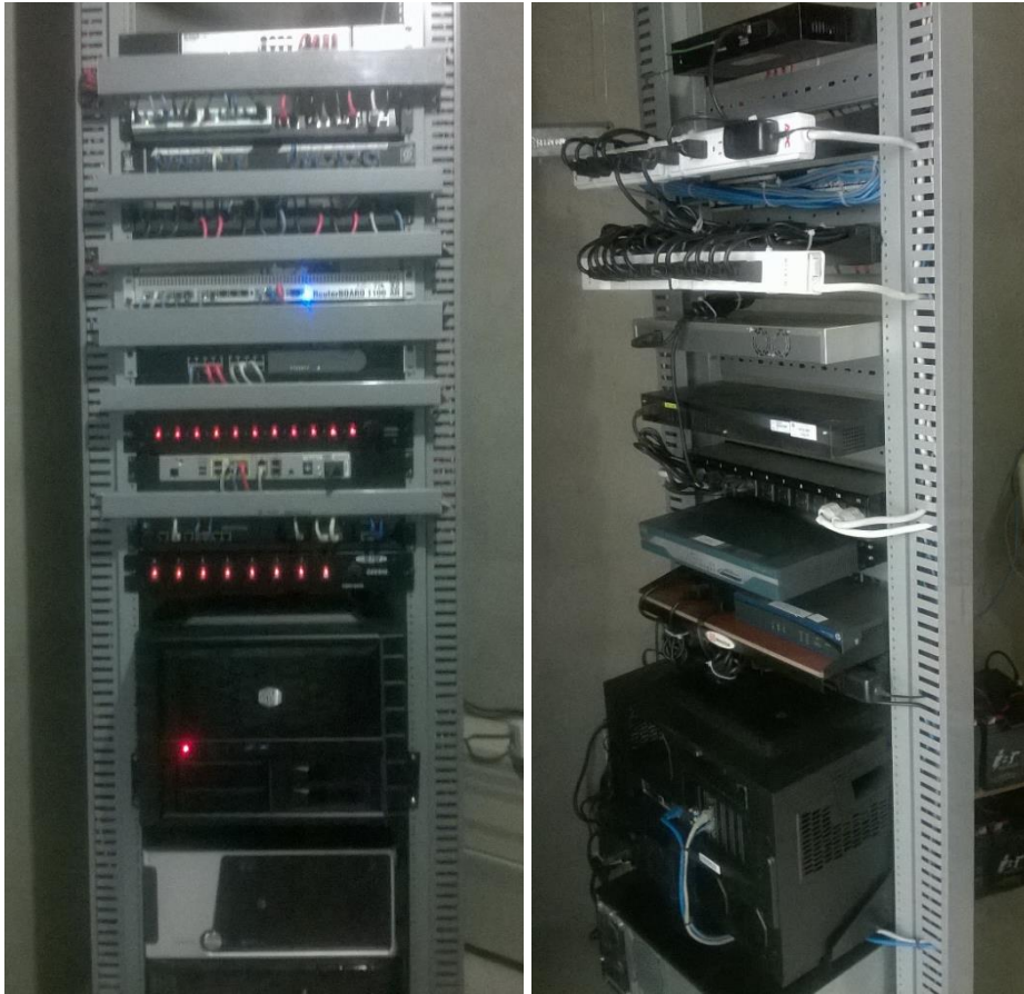
Figura 6.20 Cableado Estructurado en el Nodo Principal Fuente: Autor
