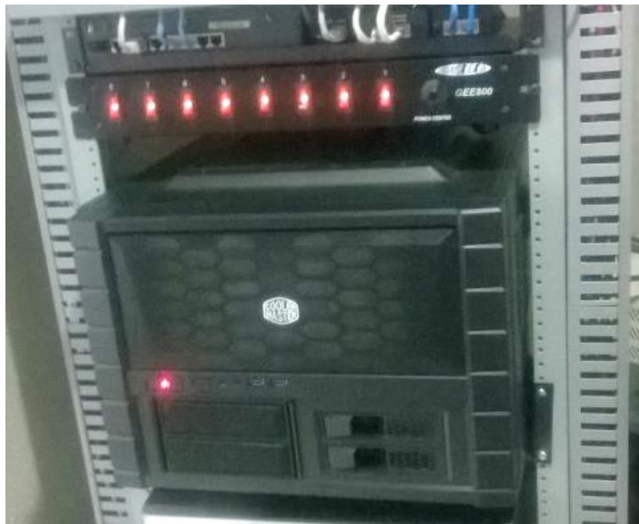
Figura 6.5 Vista del Core Router Instalado en el Rack Fuente: Autor
