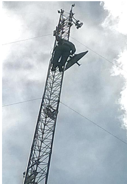
Figura 6.11 Instalación de Nuevo Enlace a Internet
