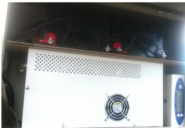
Figura 6.19 Respaldo de Energía del Nodo Secundario 3 Fuente: Autor
