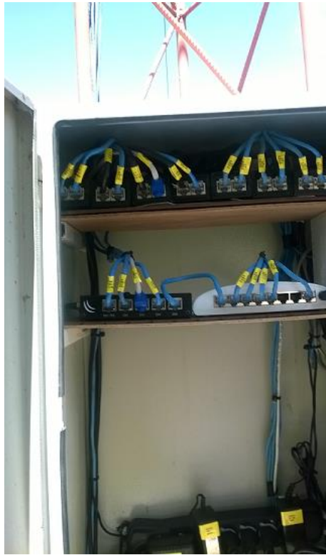
Figura 6.21 Adecuación del Cableado en el Nodo Secundario 3
