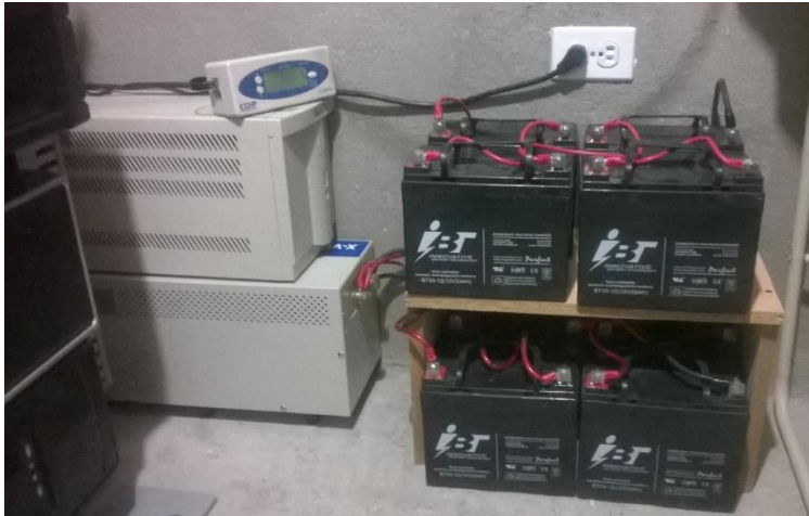
Figura 6.18 Respaldo de Energía del Nodo Principal Fuente: Autor
