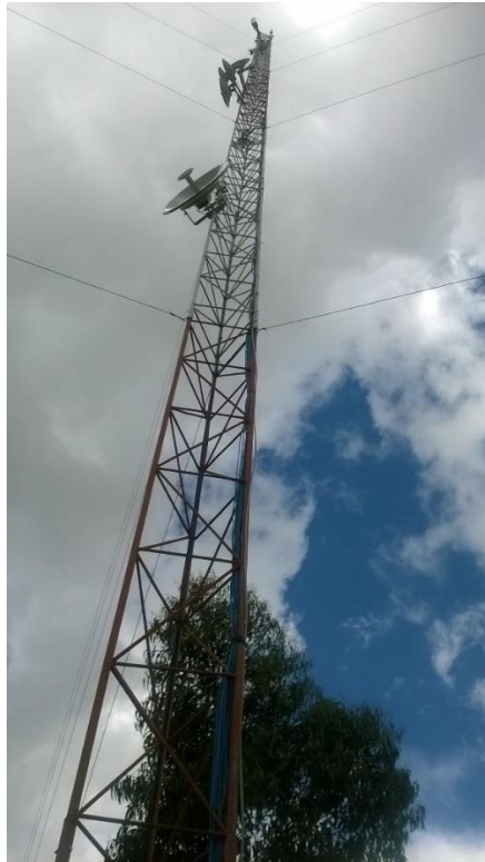
Figura 2.4 Vista de la Torres del Nodo Principal Fuente: Autor
