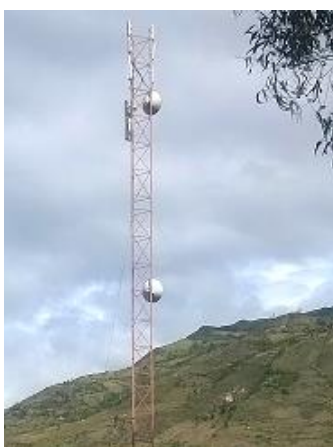
Figura 2.7 Vista del Nodo Secundario 3 Fuente: Autor
