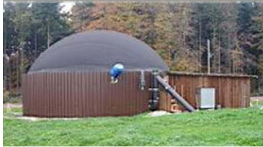
Figura 22: Digestor con tanque de almacenamiento tradicional y cúpula de polietileno
