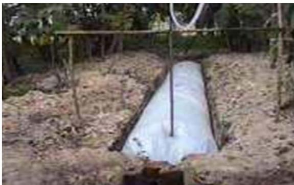
Figura 20: Biodigestor de estructura flexible
