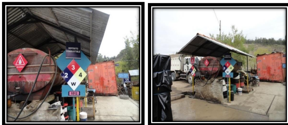
Ilustración 19. Área de Depósito de Combustible. Fuente: Los Autores.
