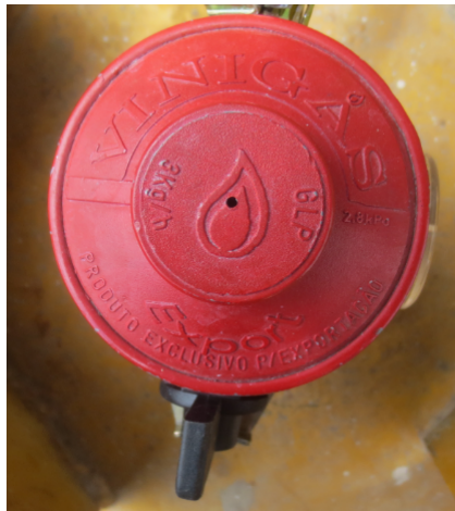
Figura 1.34: Válvula principal para el calefón analizado.
