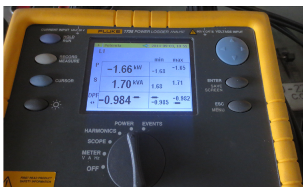
Figura 2.14: Registrador Trifásico Fluke 1735 POWER LOGGER.
