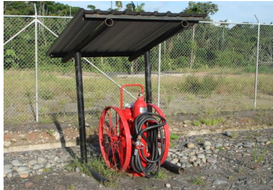
FOTOGRAFÍA No. 18: EXTINTOR MÓVIL CONTRA INCENDIOS
