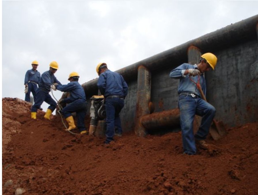
FOTOGRAFÍA No. 44: COMPACTACIÓN EXTERIOR DEL MURO
