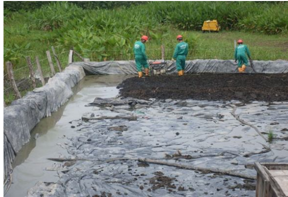
FOTOGRAFÍA No. 23: TRATAMIENTO DE LODOS CONTAMINADOS
