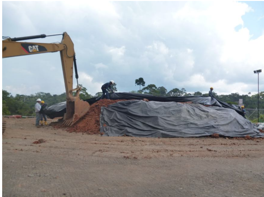
FOTOGRAFÍA No. 45: PREVENCIÓN DE LA EROSIÓN DEL SUELO
