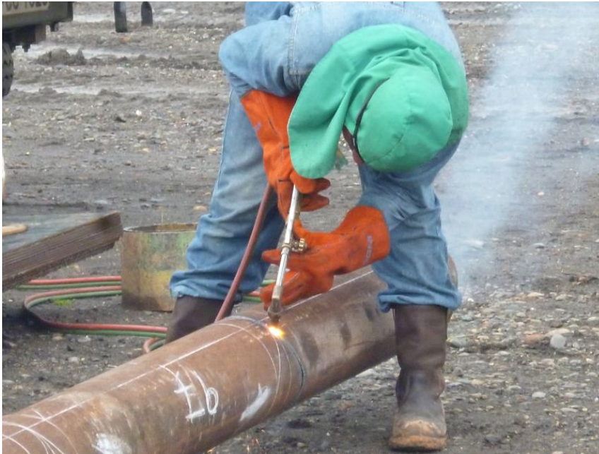
FOTOGRAFÍA No. 40: ADECUACIÓN DE PILOTES MEDIANTE OXICORTE
