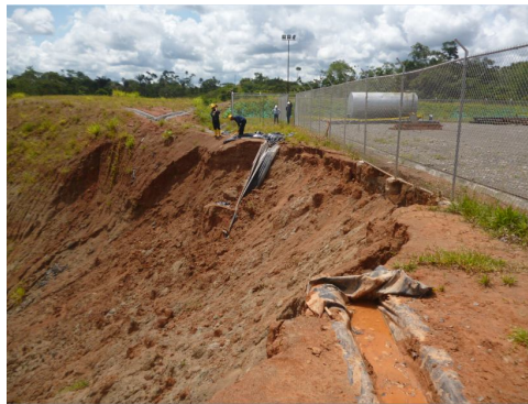
FOTOGRAFÍA No. 5: DESLIZAMIENTO EN ESTADO INICIAL
