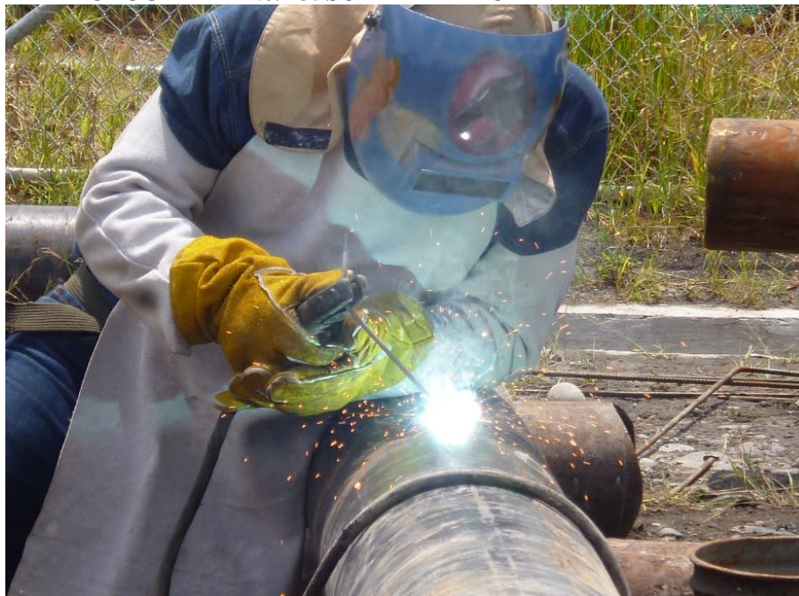
FOTOGRAFÍA No. 43: SUELDA DE TUBERÍA DE AMARRE
