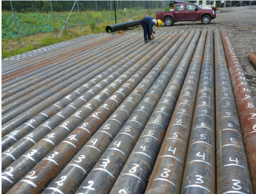
FOTOGRAFÍA No. 39: ROTULACIÓN DE PILOTES
