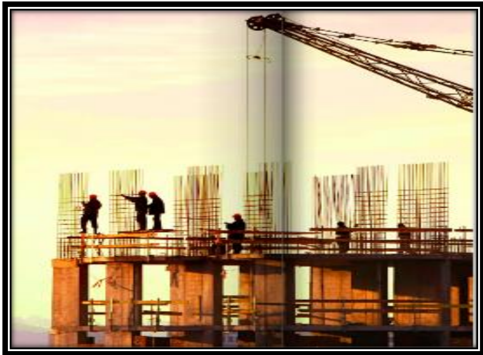
Figura 6. Construcción de infraestructuras. CAMICON, 2014
