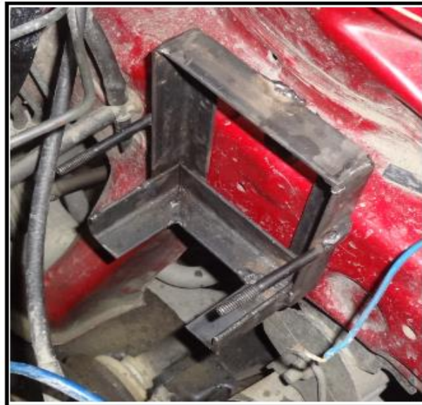
Fig. 3.26– Construcción de jaula Fuente: Los autores
