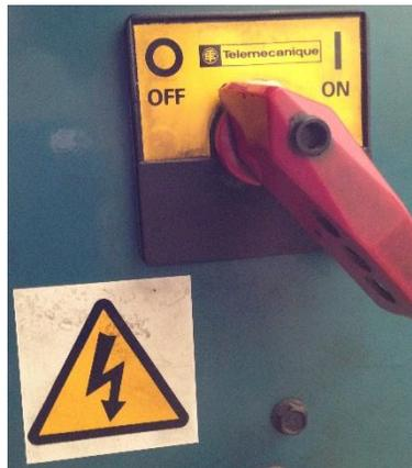
**Figura 3.23** Interruptor de encendido del banco de pruebas. **Fuente:** Autores.
