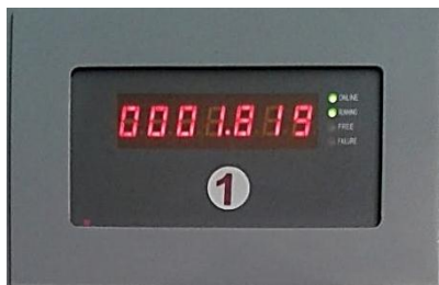
Figura 17. Control de presión.
