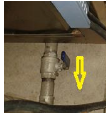
Figura 25. Válvula de desfogue.
