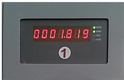
Figura 17. Control de presión.
