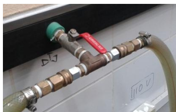
Figura 18. Válvula de distribución de agua.
