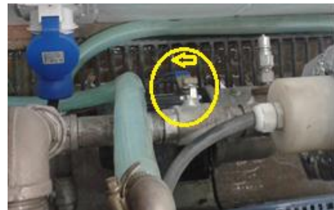
Figura 20. Válvula, control de temperatura.
