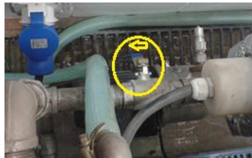
Figura 20. Válvula, control de temperatura.
