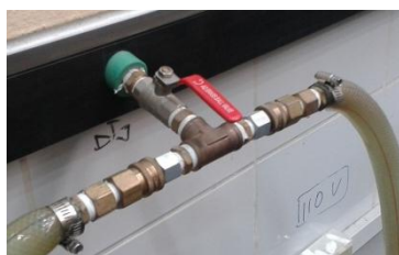
Figura 18. Válvula de distribución de agua.
