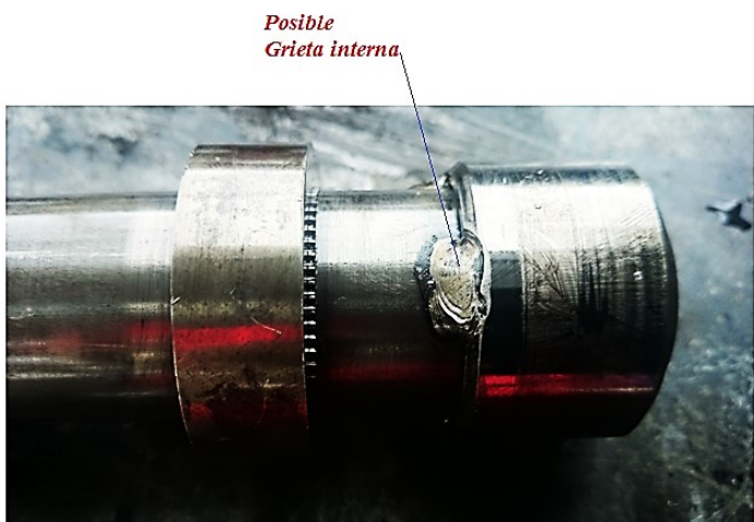
Figura 5.13: Posibles grietas internas a causa de las altas presiones.
