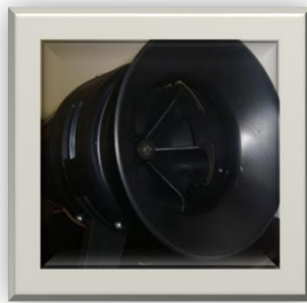
Ilustración 41: Sirena audible con turbina electromecánica ( Plan de Emergencia Caucho Industrias L.R.P., 2012 )
