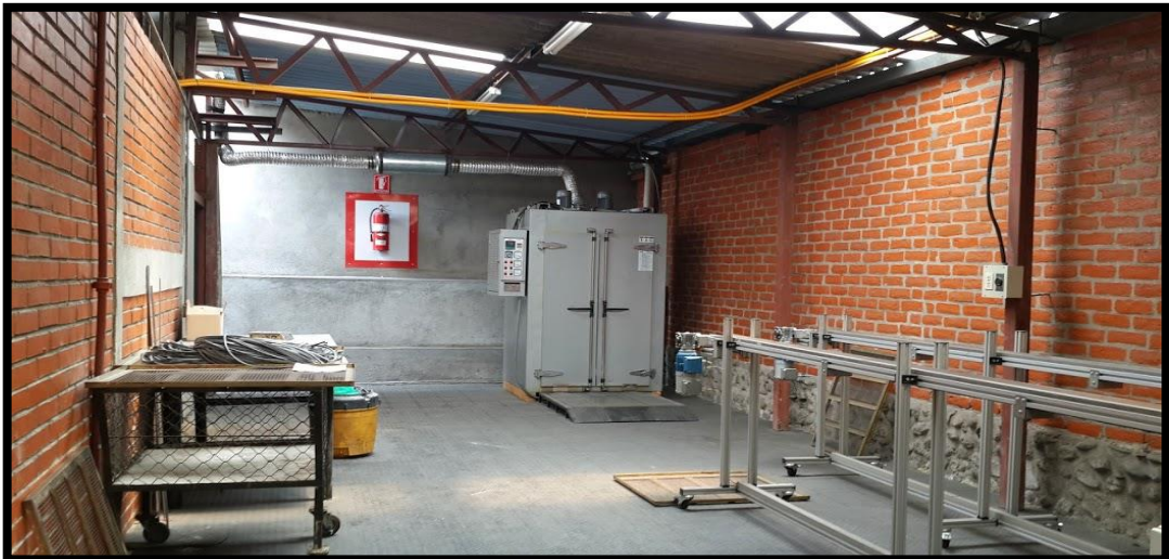
Ilustración 38: Extintor en el Área de Tratamiento Físico y Químico Fuente: Los Autores
