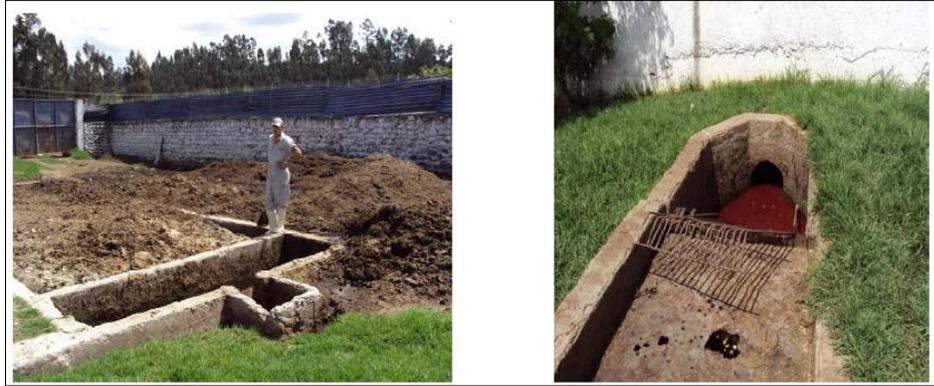
**Ilustración 10: Sistema de recolección de las aguas industriales, con rejillas y un colector final hacia el sedimentador,**
