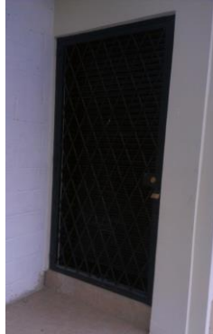
Figura 4.7 Puerta enrollable tipo lanfor y protección de hierro
