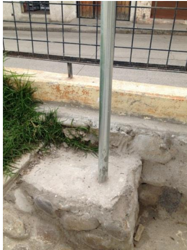
Figura 4.6 Tubo galvanizado de 2" de diámetro con una longitud de 3 metros
