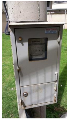
Figura 4.5 Caja Metálica para medidor de energía eléctrica ubicada sobre poste
