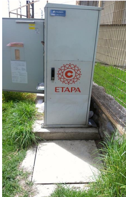
Figura 4.1 Cámara ubicada al costado del bloque de cemento.
