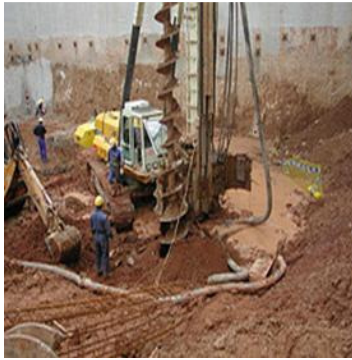
Figura 10: Construcción de pilotes
