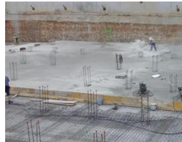
Figura 6: Losas de cimentación
