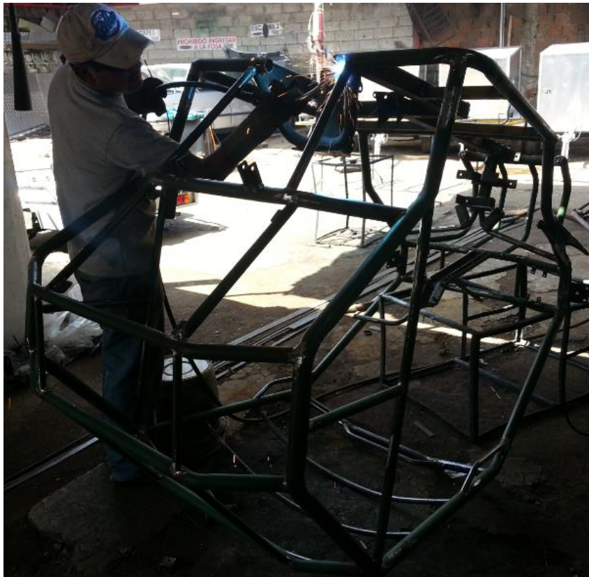
Figura 4.6 Soldado estructura principal.
