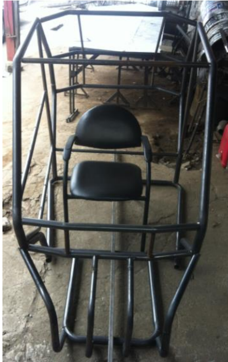
Figura 4.3 Armado de jaula de seguridad.
