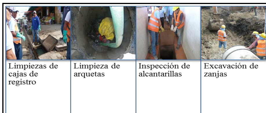
Imagen 7: Actividades del Proceso de Alcantarillado
