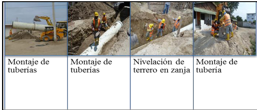
Imagen 12: Jornada de trabajo en el Proceso de Alcantarillado
