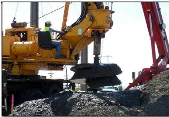
Fig. N° 1.2-7: Perforación de cimentaciones para montaje de Torres.
