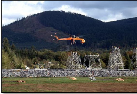
Fig. N° 1.2-6: Uso de Helicópteros en montaje de Torres.
