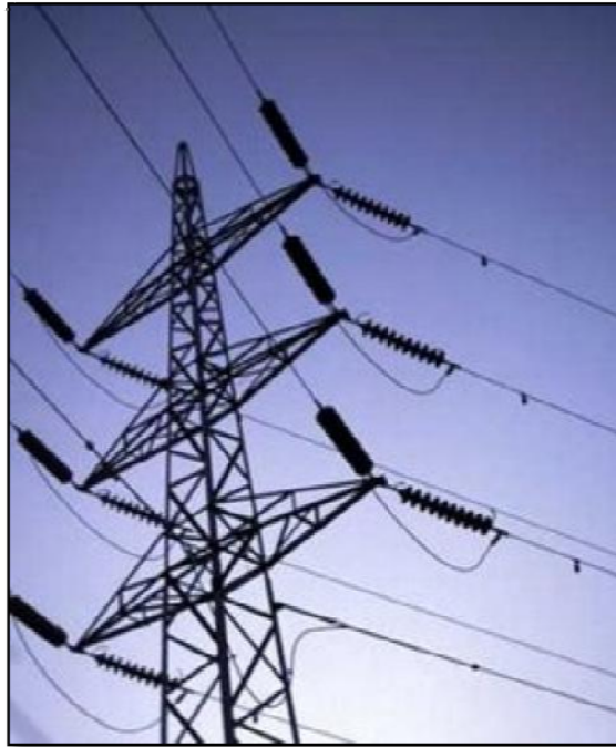
Fig. N° 1.4-3: Torre de anclaje angular.
