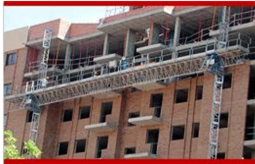
Figura 23. Plataforma sobre mástil doble.
