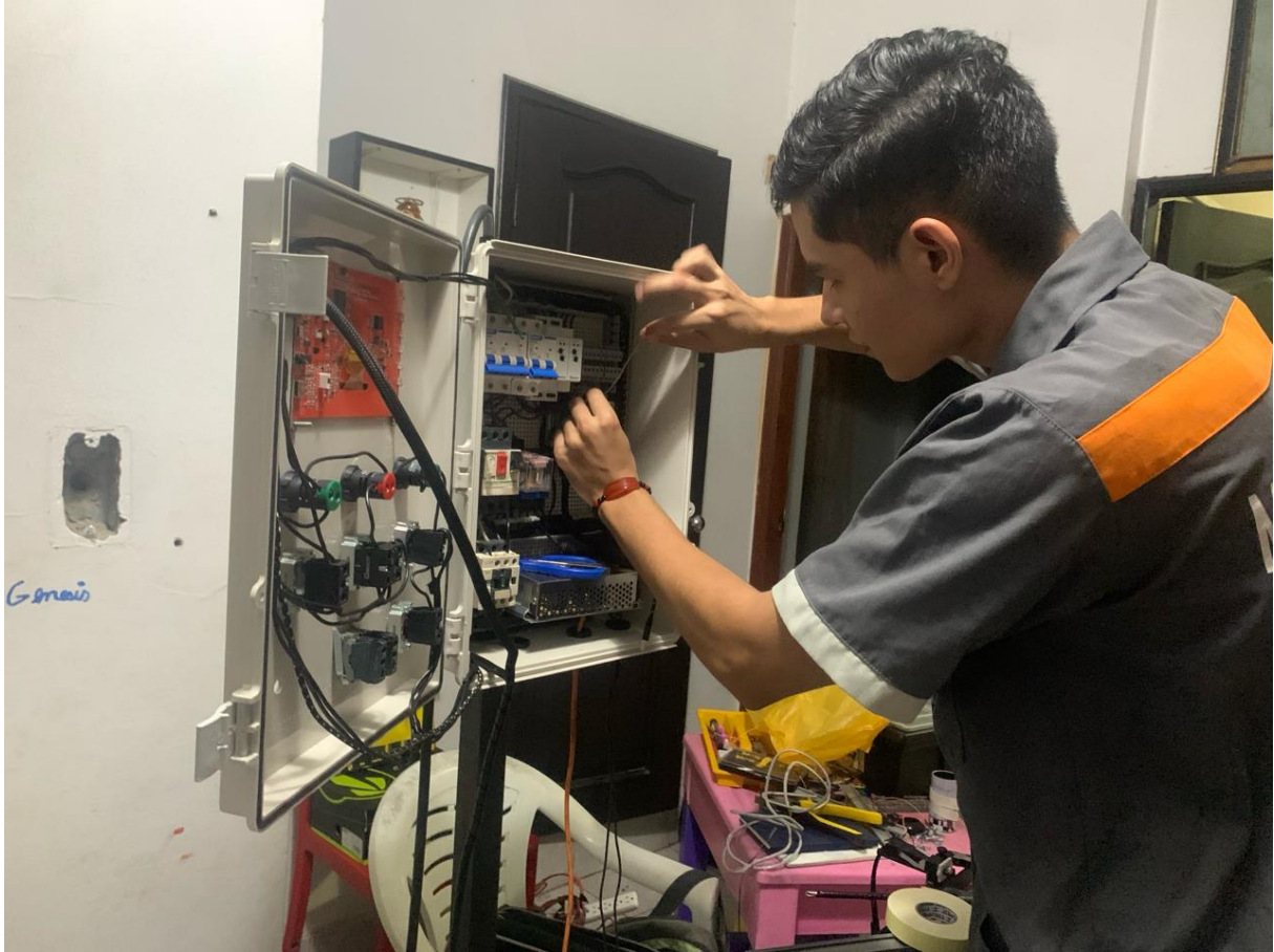
Figura 117. Instalación del panel de control. Fuente: Elaborado por autores.
