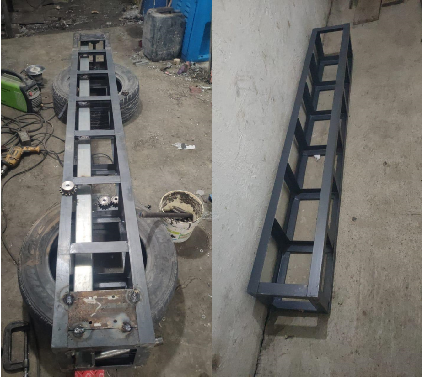
Figura 99: Estructura torre porta film ensamblada.
