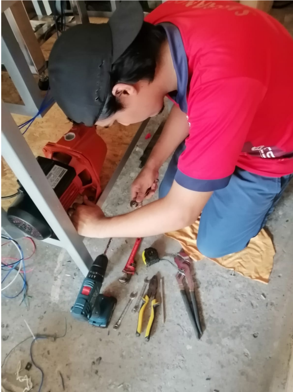
Figura 103. Instalación de bomba Trifásica al soporte de madera de la estructura metálica, por A. Valarezo y R. Izquierdo.
