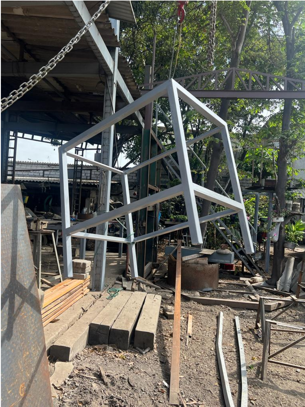
Figura 98. Soporte de la estructura metálica, por A. Valarezo y R. Izquierdo.
