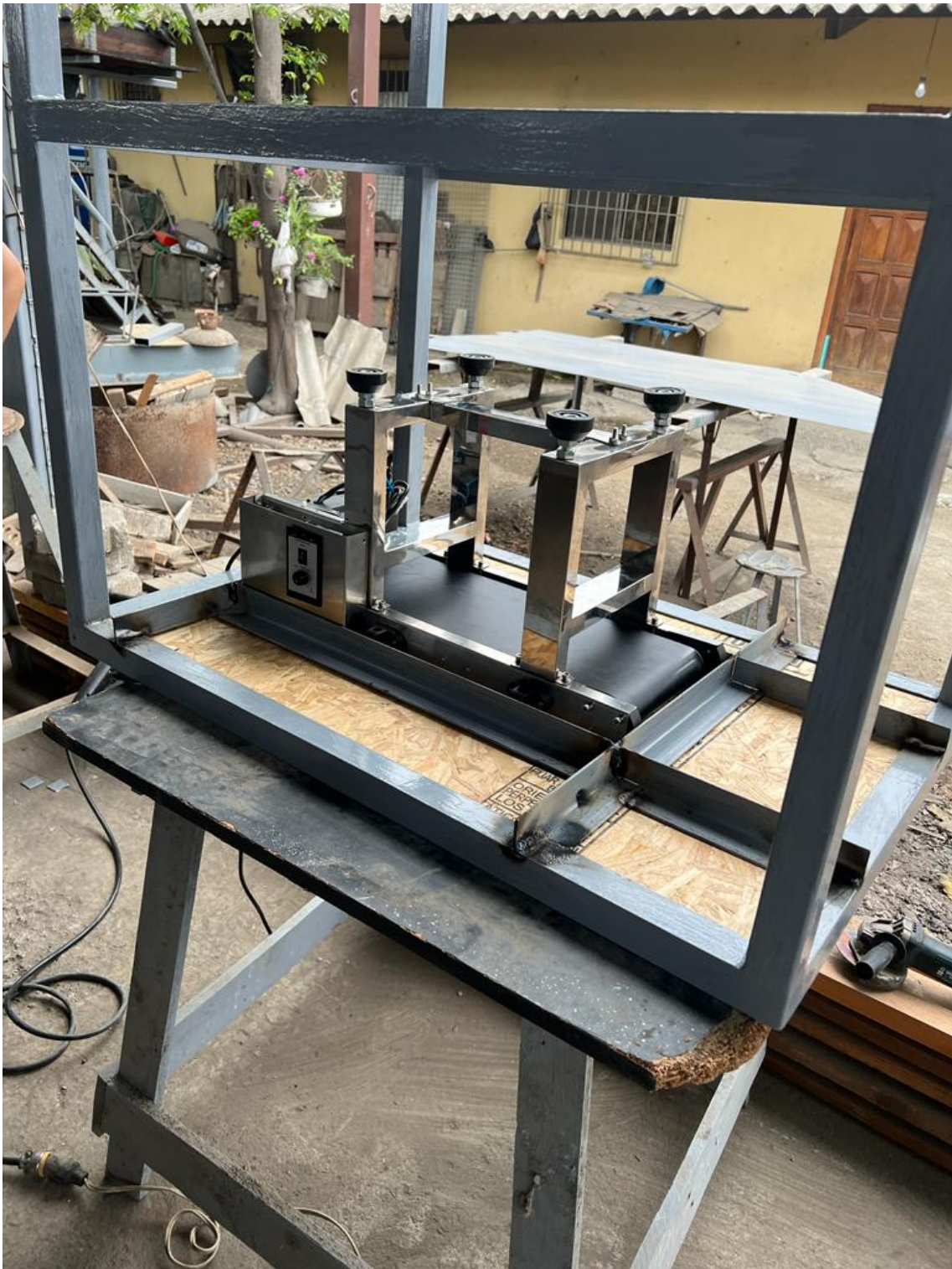
Figura 99. Montaje de banda transportadora junto con la estructura metálica, por A. Valarezo y R. Izquierdo.
