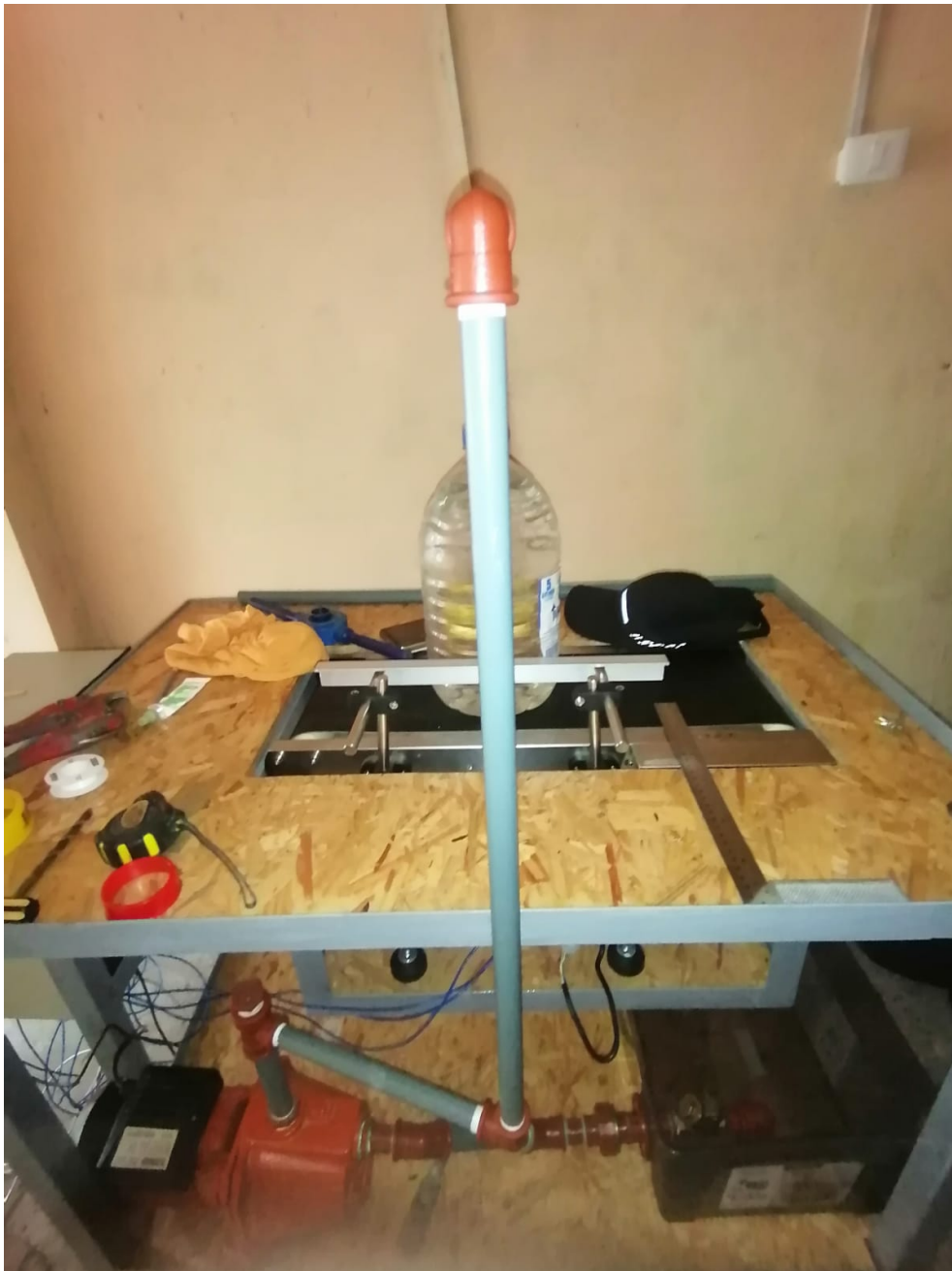
Figura 104. Colocación de tuberías para el traslado de agua desde el reservorio principal, por A. Valarezo y R. Izquierdo.
