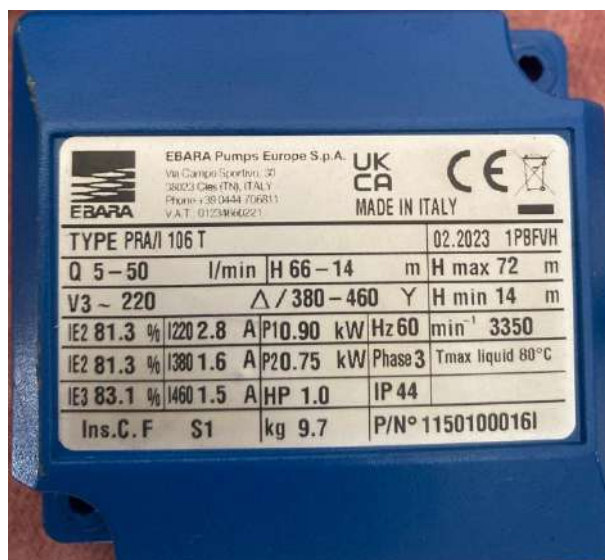
Figura 14. Especificaciones de la bomba, fuente autores.
