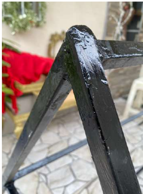
Figura 45. Cordón de soldadura en una unión triple, fuente autores.
