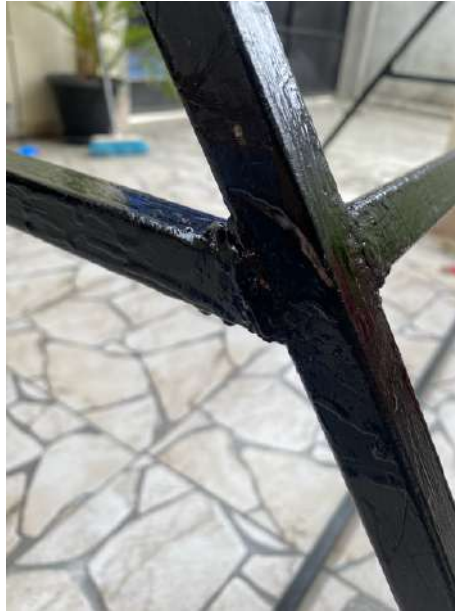
Figura 46. Cordón de soldadura de los soportes laterales, fuente autores.
