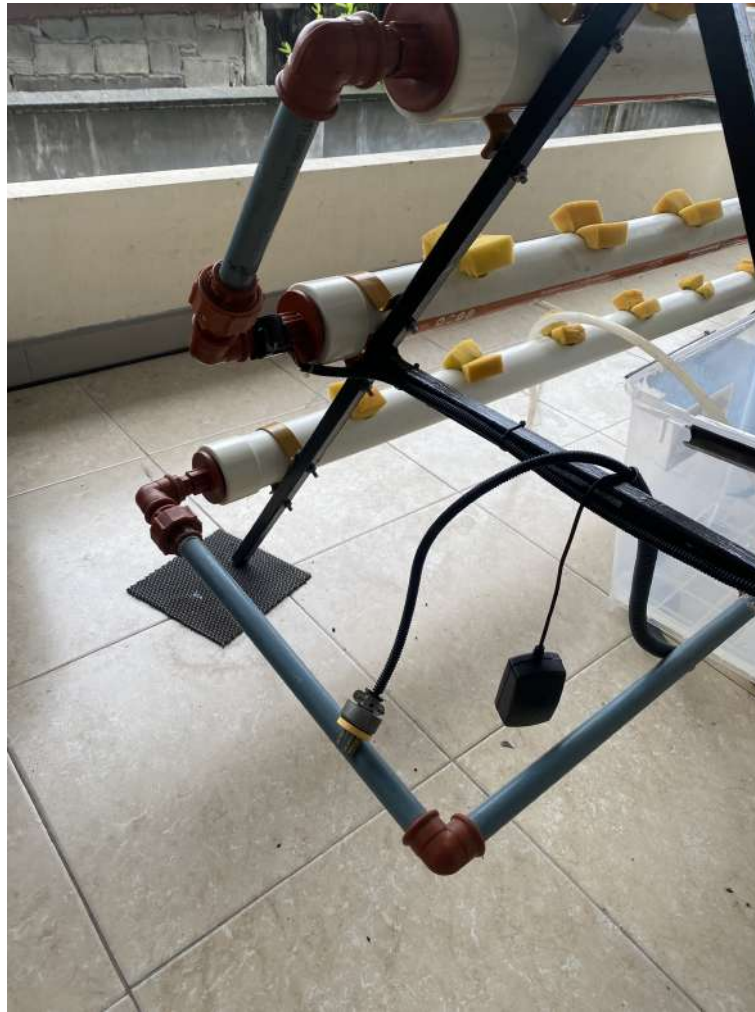
Figura 25. Uniones de tuberías del lado izquierdo, fuente autores.
