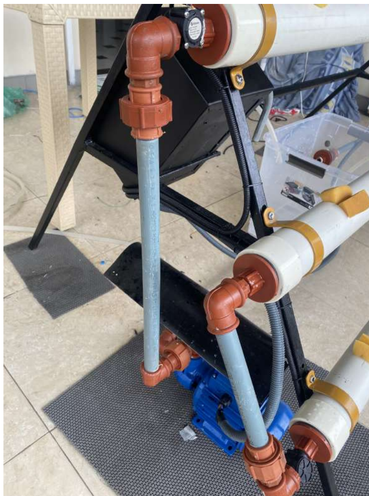
Figura 24. Uniones de tuberías del lado derecho, fuente autores.
