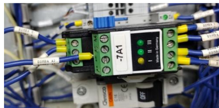
Figura 32. Instalación del controlador Kaleja D-73553
