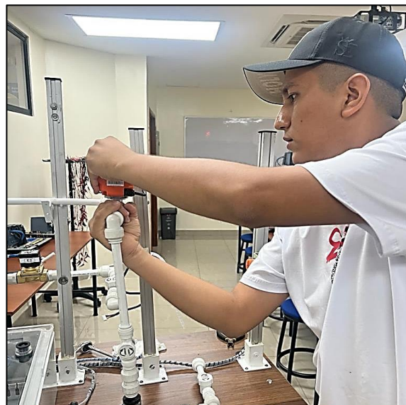
Fig. 21.- Montaje de Electroválvula Proporcional Motorizada
