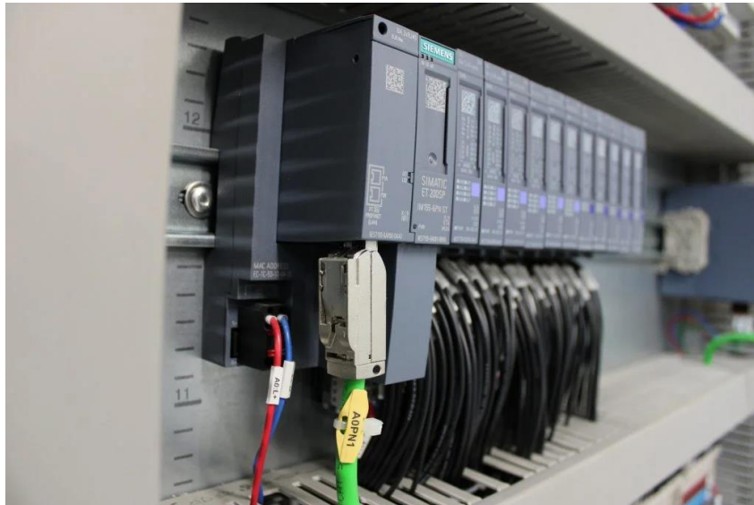
Fig. 2.- Periferia Descentralizada ET200S. (Sydec, 2023)
