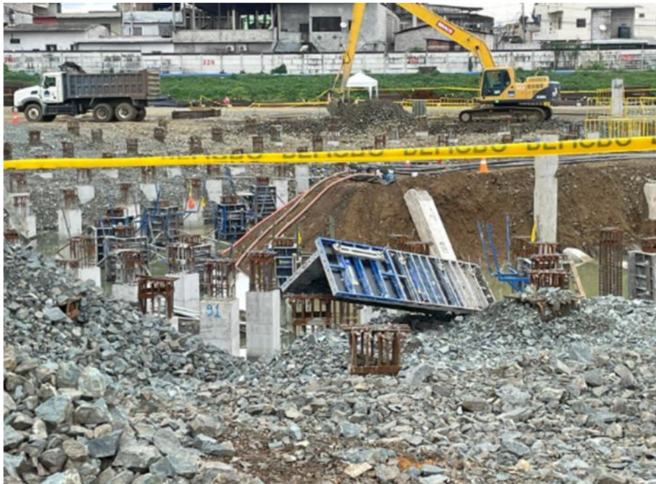
Imagen 49. Hormigón F'c=420 kg/cm 2 de resistencia temprana a los 3 días, usado para pilotes de tanque clarificador.
