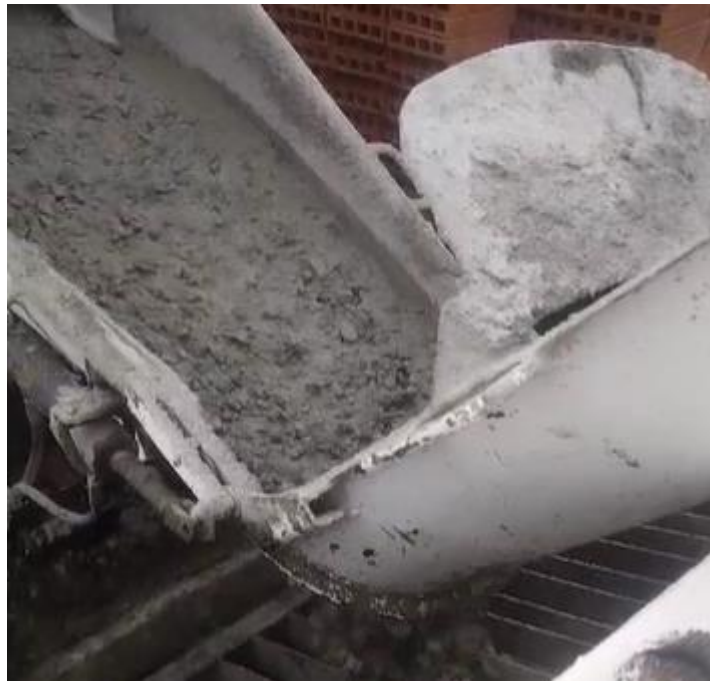
Imagen 1. Vaciado de Hormigón premezclado en bomba estacionaria
