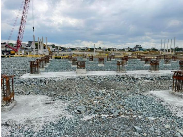
Imagen 47. Hormigón F'c=140 kg/cm 2 usado para replantillo de vigas y cabezales en pilotes.
