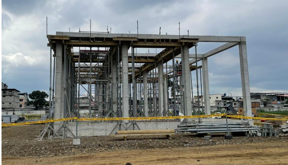
Imagen 50. Hormigón F'c=350 kg/cm 2 especial, usado para muros de tanques de agua
