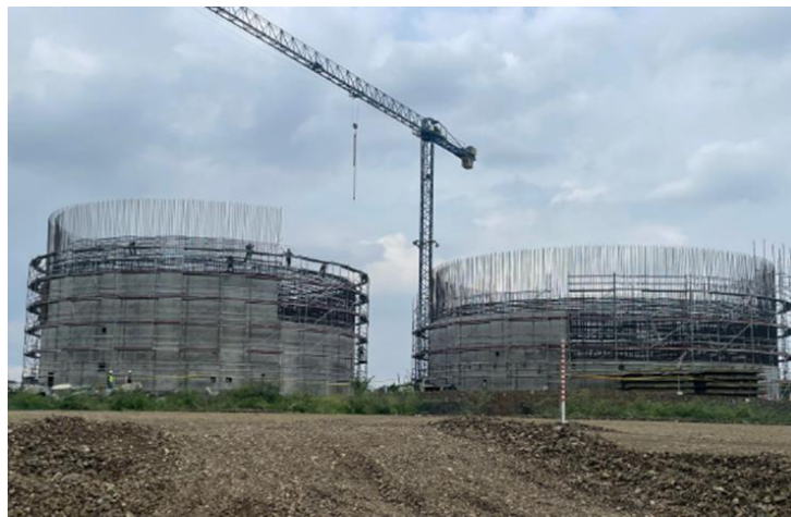
Imagen 48. Hormigón F'c=350 kg/cm 2 especial, usado para muros de tanques de agua
