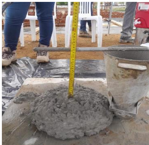
Imagen 22. Toma de asentamiento de Hormigón 420 Kg/cm 2 en obra
