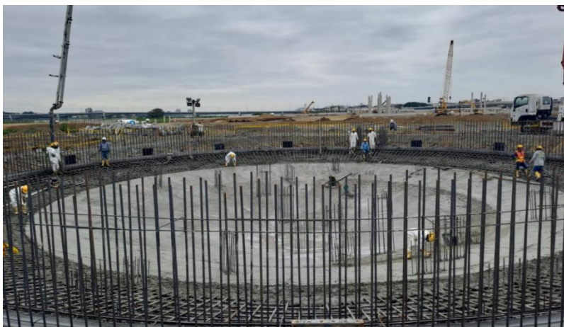
Imagen 5. Aplicación de Hormigón 350 Kg/cm 2 con acabado liso
