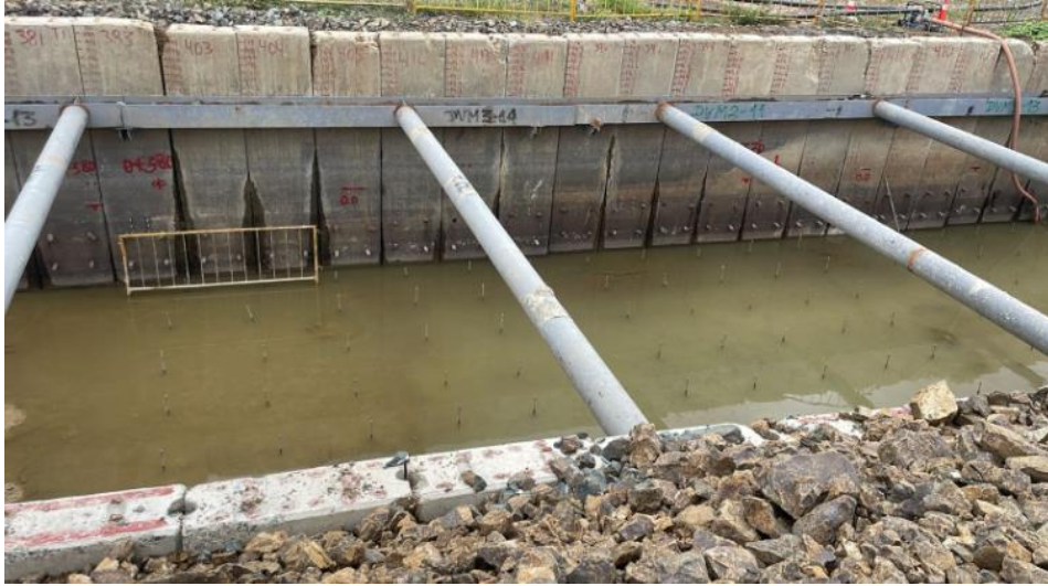
Imagen 53. Hormigón F'c=350 kg/cm 2 de resistencia, para canal.
