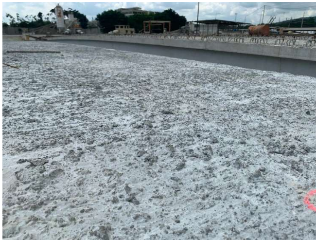
Ilustración 28. Acabado de losa doble T.
