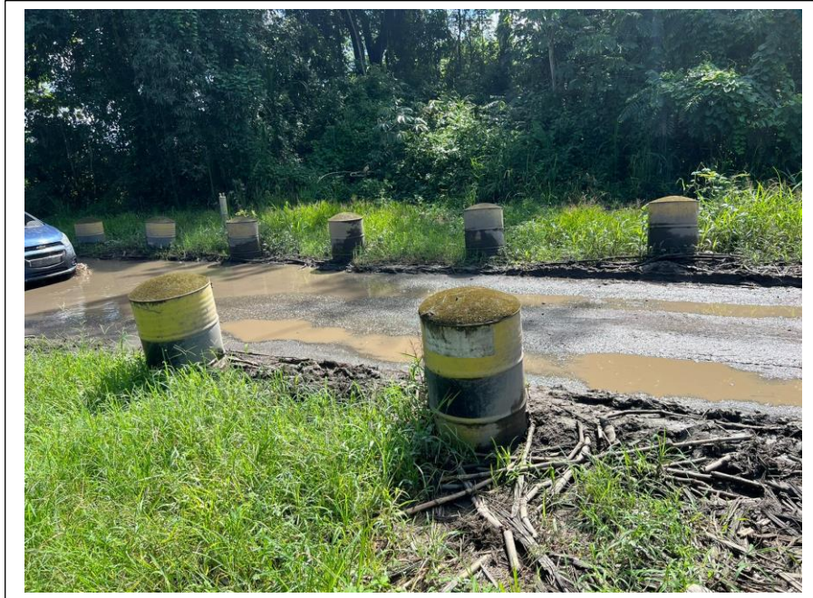
Imagen 46. Vía de acceso al puente
