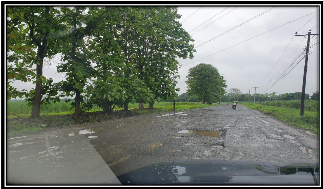
Ilustración 2 Estado de la Vía
