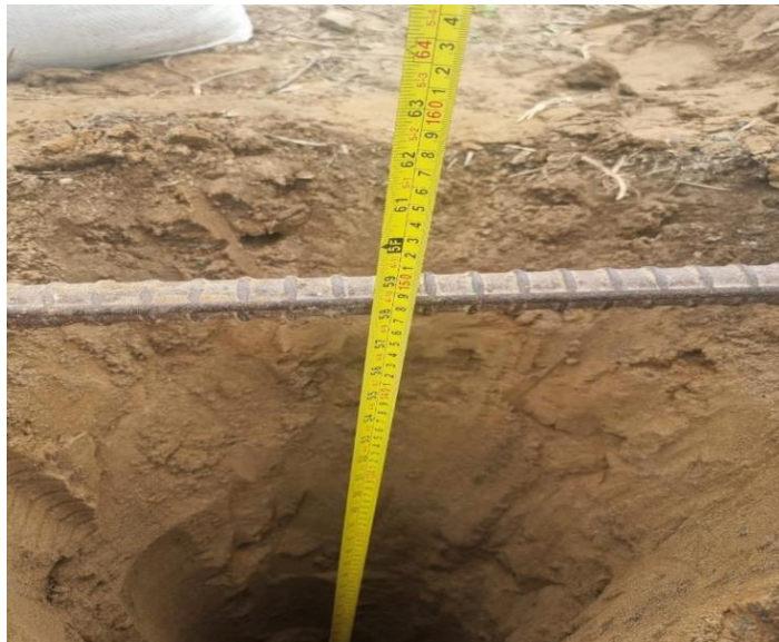
Ilustración 42 Medición de la profundidad de la calicata 1
