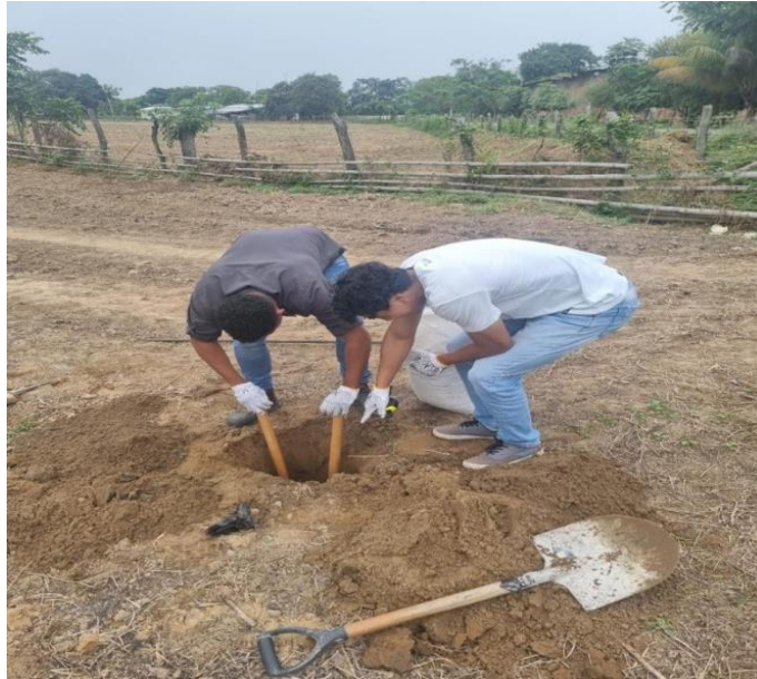
Ilustración 41 Excavación manual de la calicata 1
