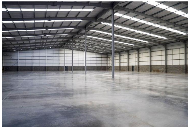
Ilustración 1 - Estructura de acero - Julio Morales
