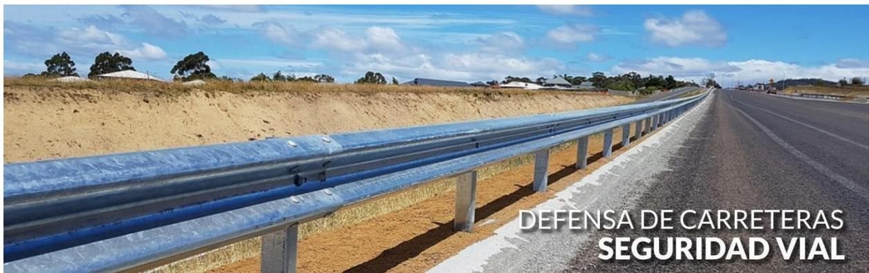
*Ilustración 43 Barandas de seguridad para carreteras*
