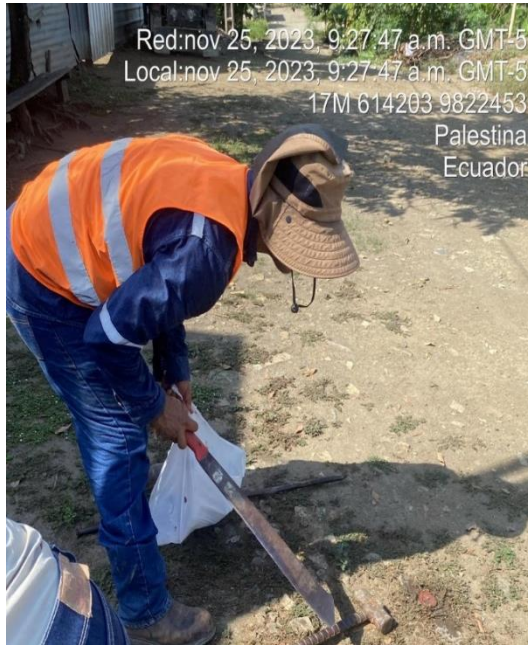
Ilustración 37.- Señalización del auxiliar #6
