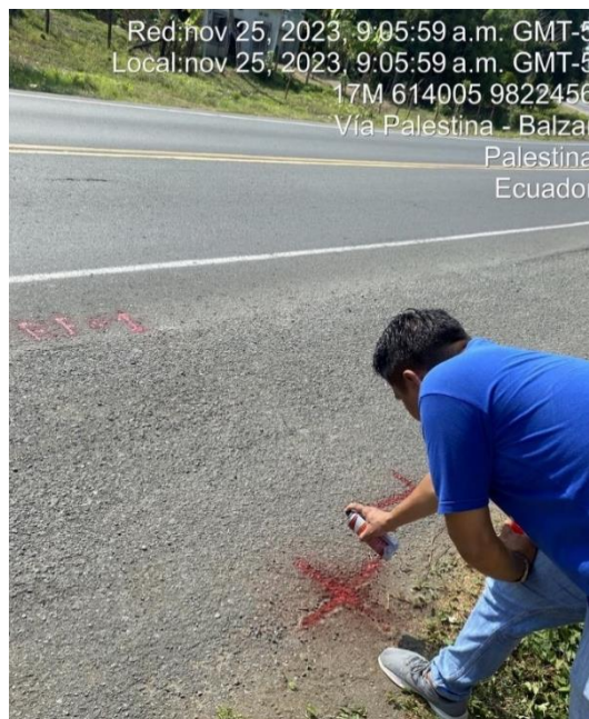
Ilustración 34.- Señalización del primer punto de referencia
