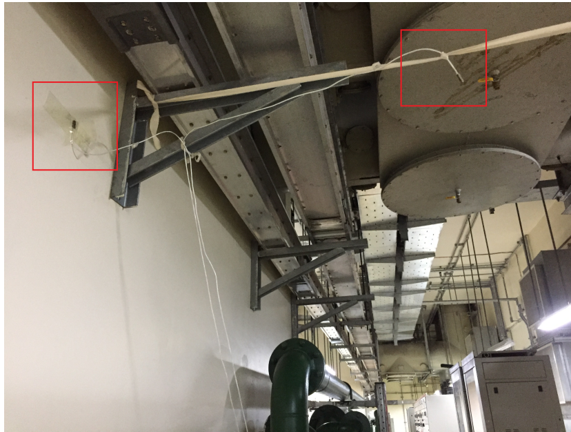
Figura 4.6: Instalación de RTD's en la superficie a evaluar y el ambiente. Fuente: Autor
