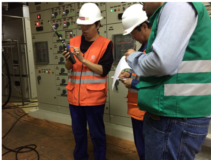
Figura 4.5: Medición de velocidad del viento con anemómetro digital. Fuente: Autor
