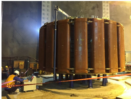
Figura 2.2: Rotor de polos salientes turbina hidráulica marca Harbin 162.3 [MW] Fuente: Autor
