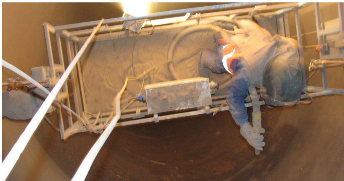
Figura 8. Trabajos de Granallado con el EPP correcto.
