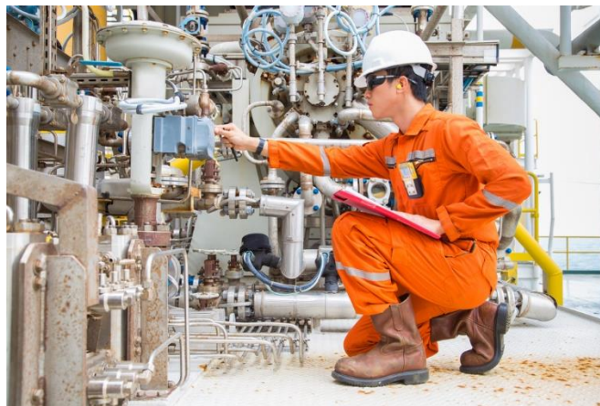
Figura 11. Técnico Ejecutando Inspección Visual
