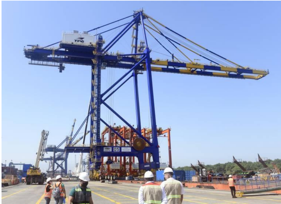
Figura 2.20 Grúa Pórtico Movil
