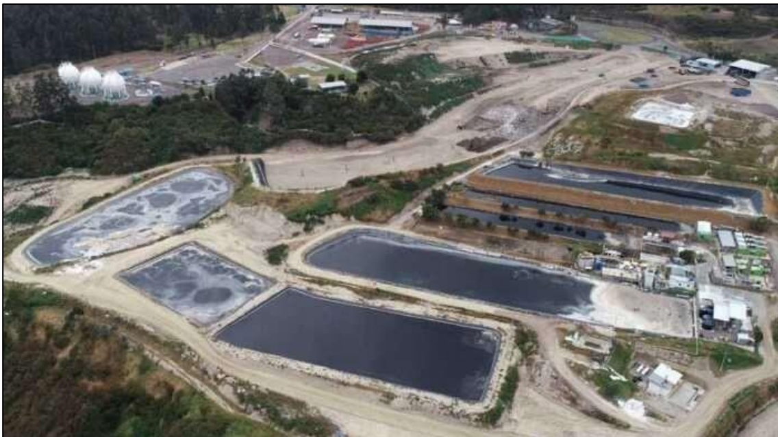
Relleno Sanitario El Inga
