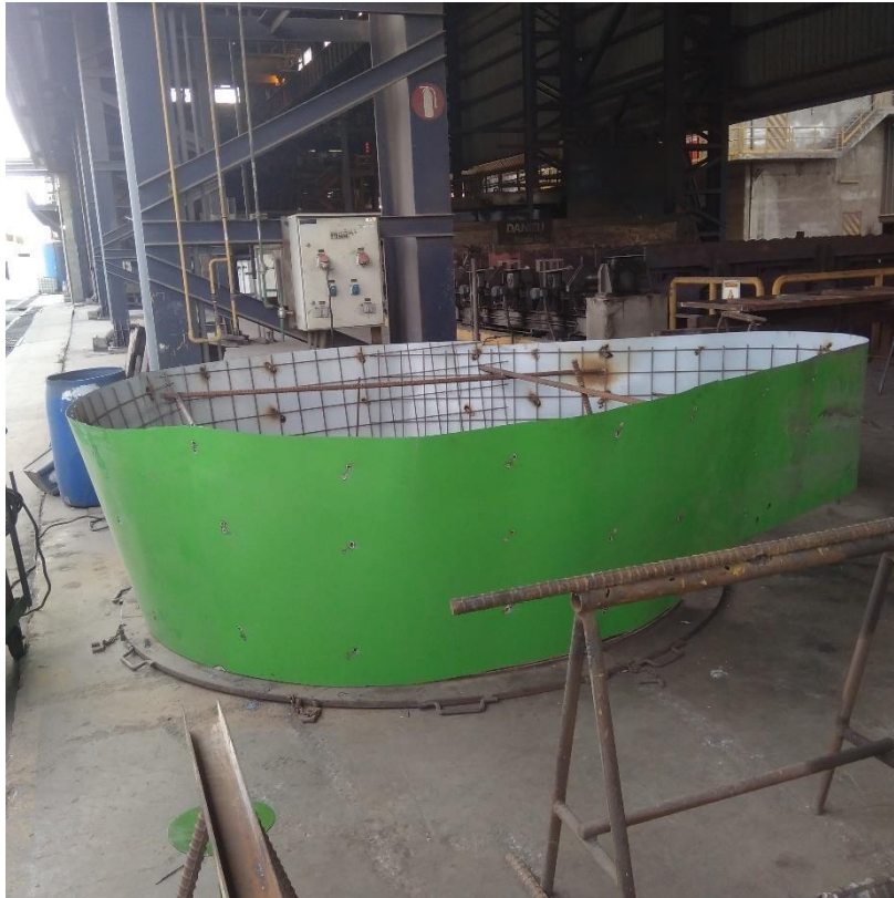
Figura 3.5: Recubrimiento del molde
