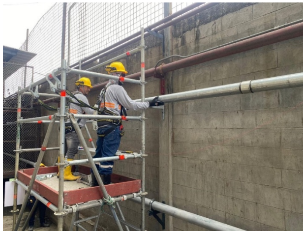
Figura 42. Colocación de tubería rígida con ayuda de andamio unidimensionales, arneses y eslingas
