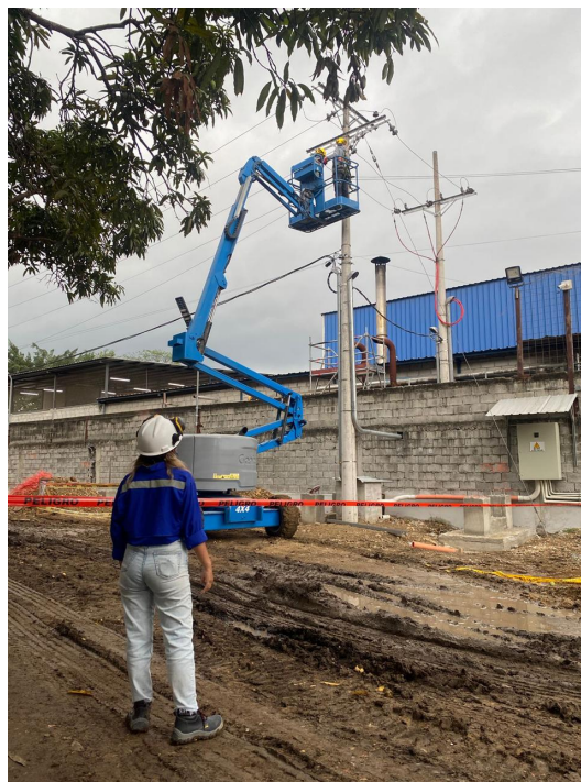
Figura 46. Colocación de cable a poste eléctrico en frío con ayuda de brazo articulado (manlift), arneses, eslingas
