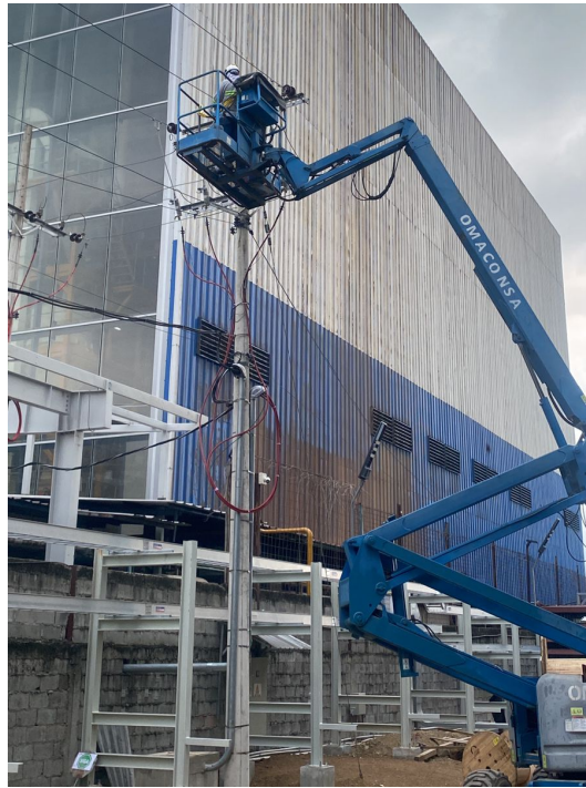
Figura 47. Mantenimiento de líneas aéreas des-energizadas
