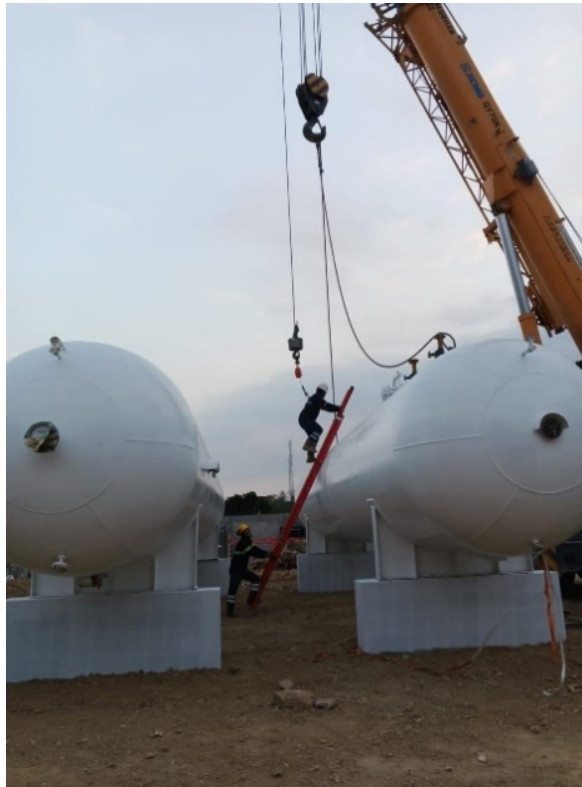
Figura 41. Instalación de accesorios de izaje con ayuda de retráctil certificado
