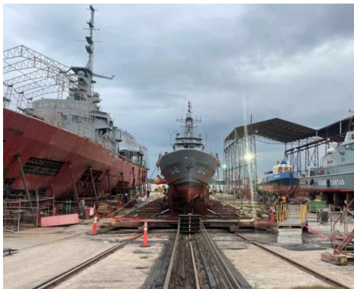
Figura 3.1 Inspección del área de trabajo en Pre-Granallado
