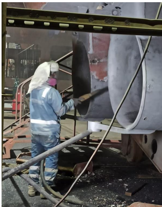
Figura 1.1 Aplicación de granallado en el casco de la popa del Remolcador Isabella
