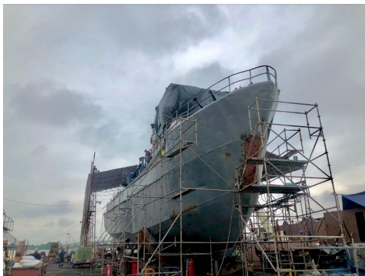
Figura 3.2 Uso de andamios en el proceso de granallado en el barco M. Cristina
