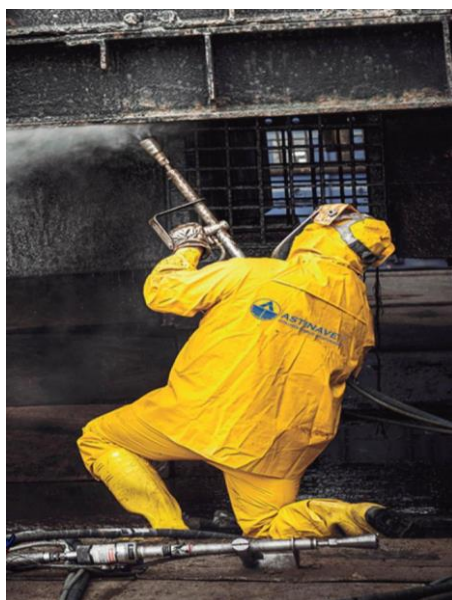
Figura 1.3 Operadores de granallado de ASTINAVE S.P.
