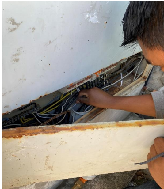
Figura 8: Medición del calibre de conductores para las líneas de distribución de la urbanización.
