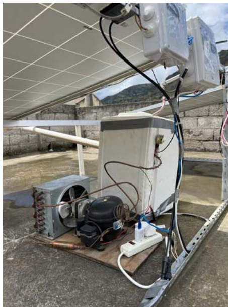
Figura 3.23: Montaje Final del sistema Chiller en el Sistema Fotovoltaico.
