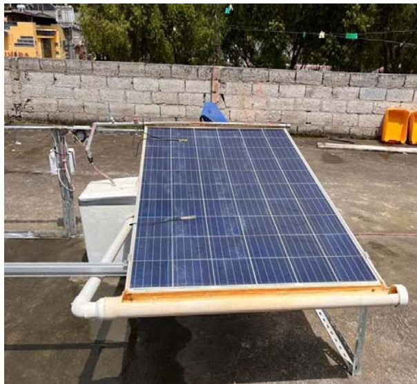
Figura 3.18: Montaje del sistema de recirculación de Agua.
