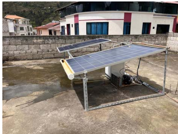
Figura 3.16: Montaje del Sistema Fotovoltaico.
