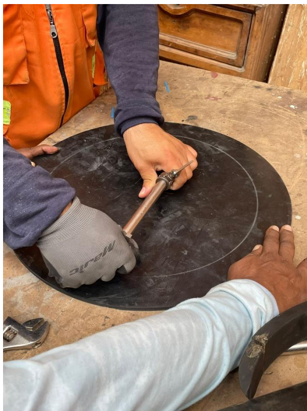
Figura 31.- Medidas y ajustes al tapón de goma
