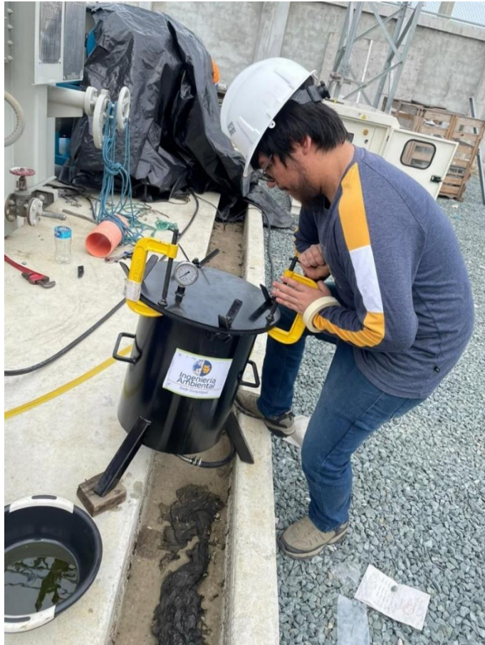
Revisión del sellado hermético del filtro previo a ponerlo en operación.
