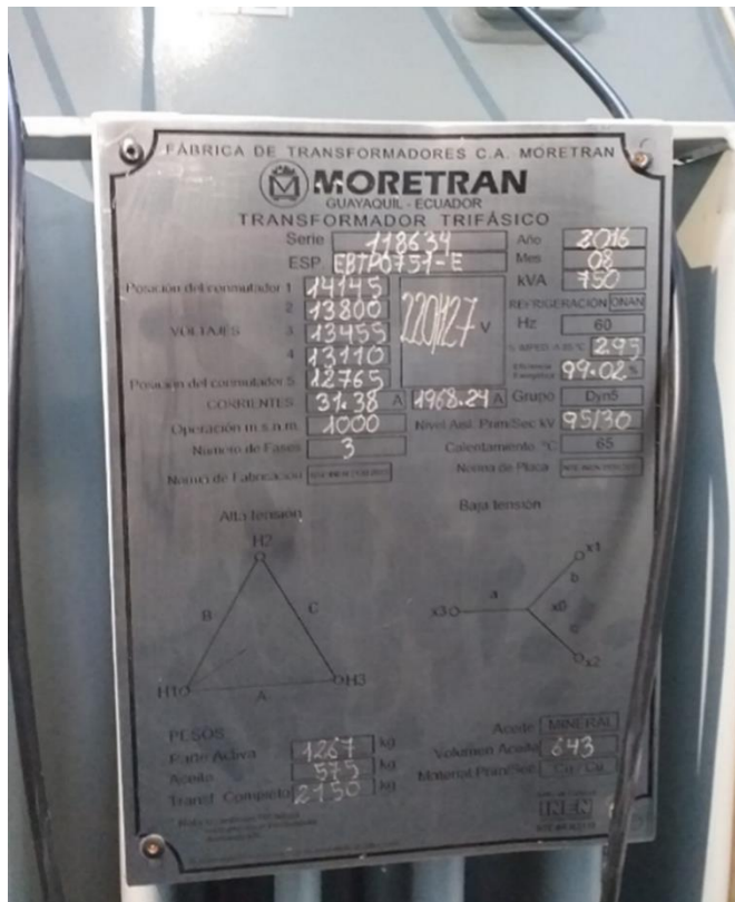
Figura 26. Datos de placa del transformador de 750 KVA, edificio E Universidad Politécnica Salesiana.
