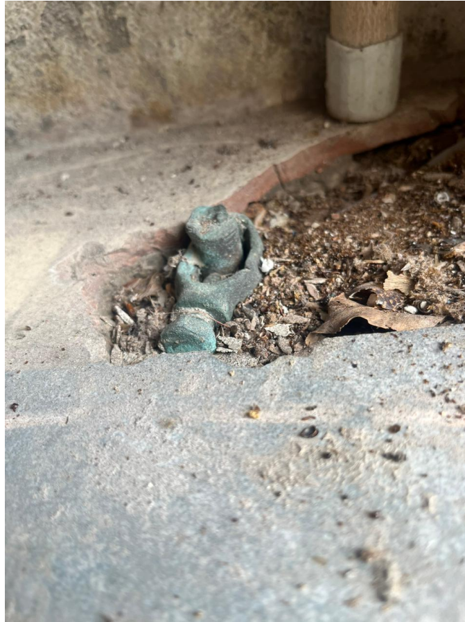
Figura 34. Puesta a tierra del taller
