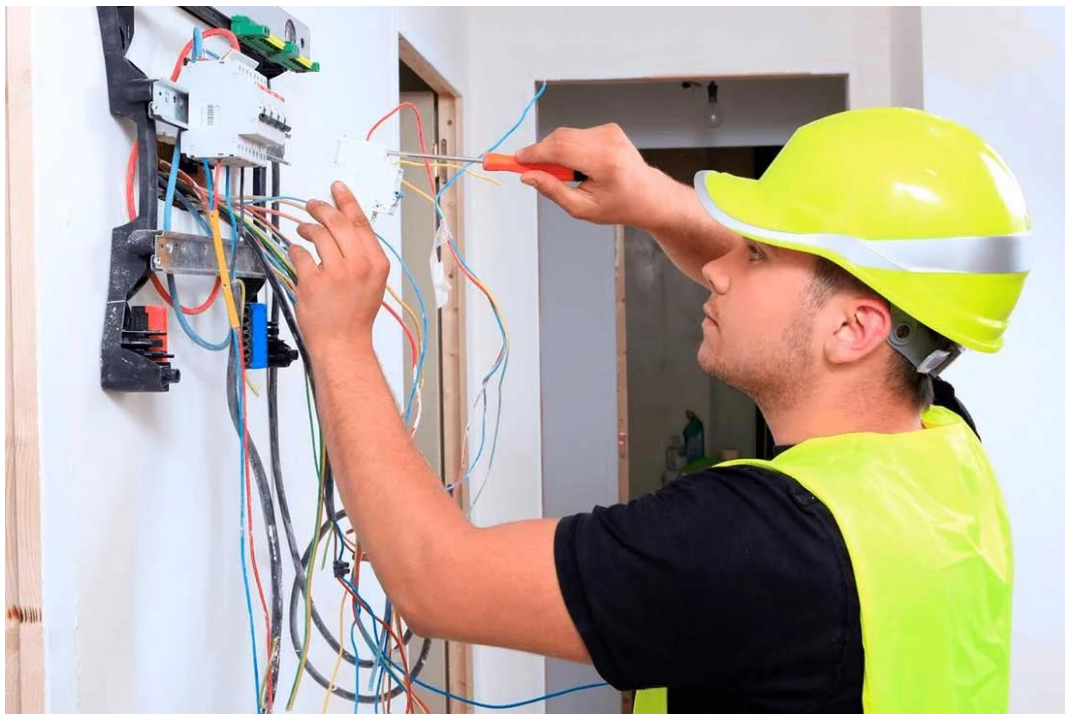
Figura 1. Instalaciones eléctricas residenciales en módulo didáctico
