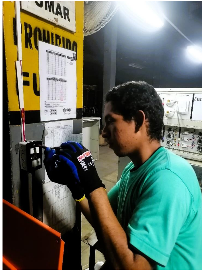
Figura 7. Instalación interruptores dentro de viviendas
