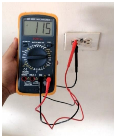
Figura 5. Equipo de medición en instalaciones eléctricas
