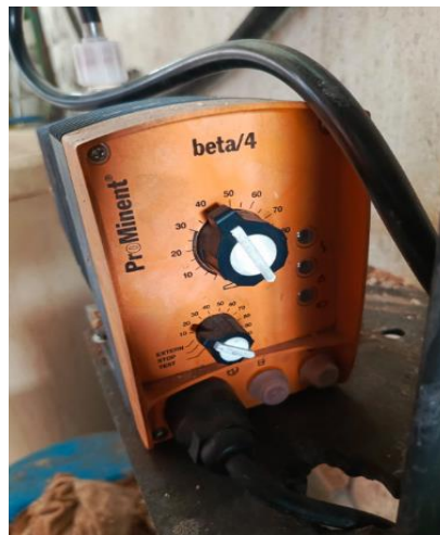
Figura 14. Dosificadora de químicos en el HAIAM.
