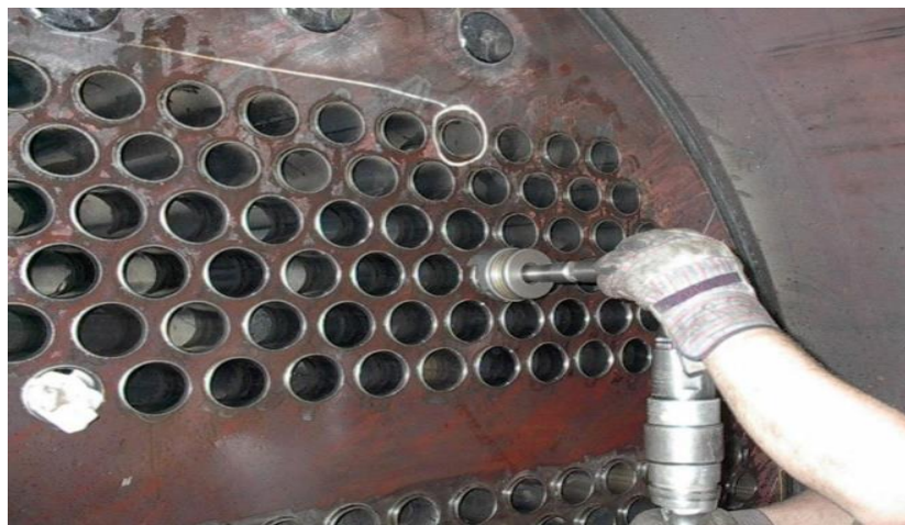
Figura 8. Instalación de tubos para una caldera Piro-tubular [30].
