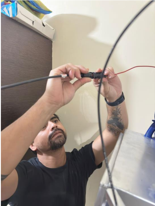
Figura 35 Conexión de cables con MC-4
