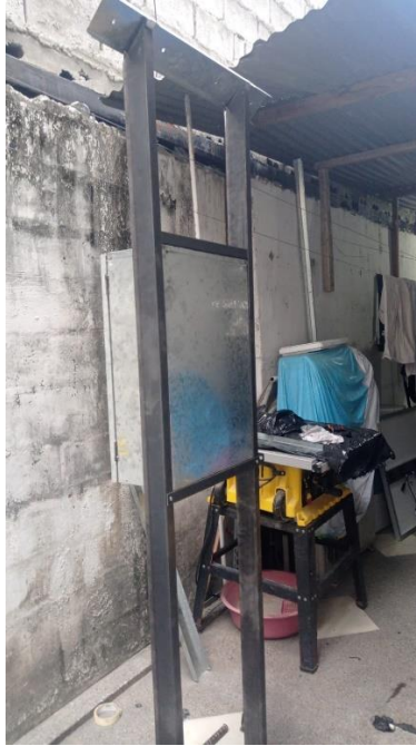
Figura 20 Estructura de soporte de panel y electrónica
