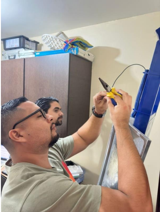
Figura 34 Preparación de cable para conectores
