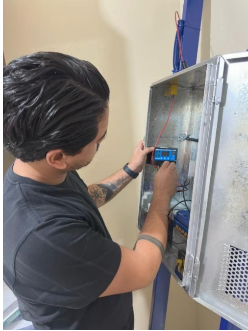
Figura 39 Acoplamiento de cables en controlador de carga
